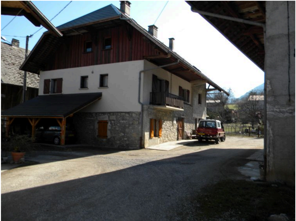
Bâtiment d'habitation d'une ancienne ferme sur cour (2008 B8 1077, 1078).
