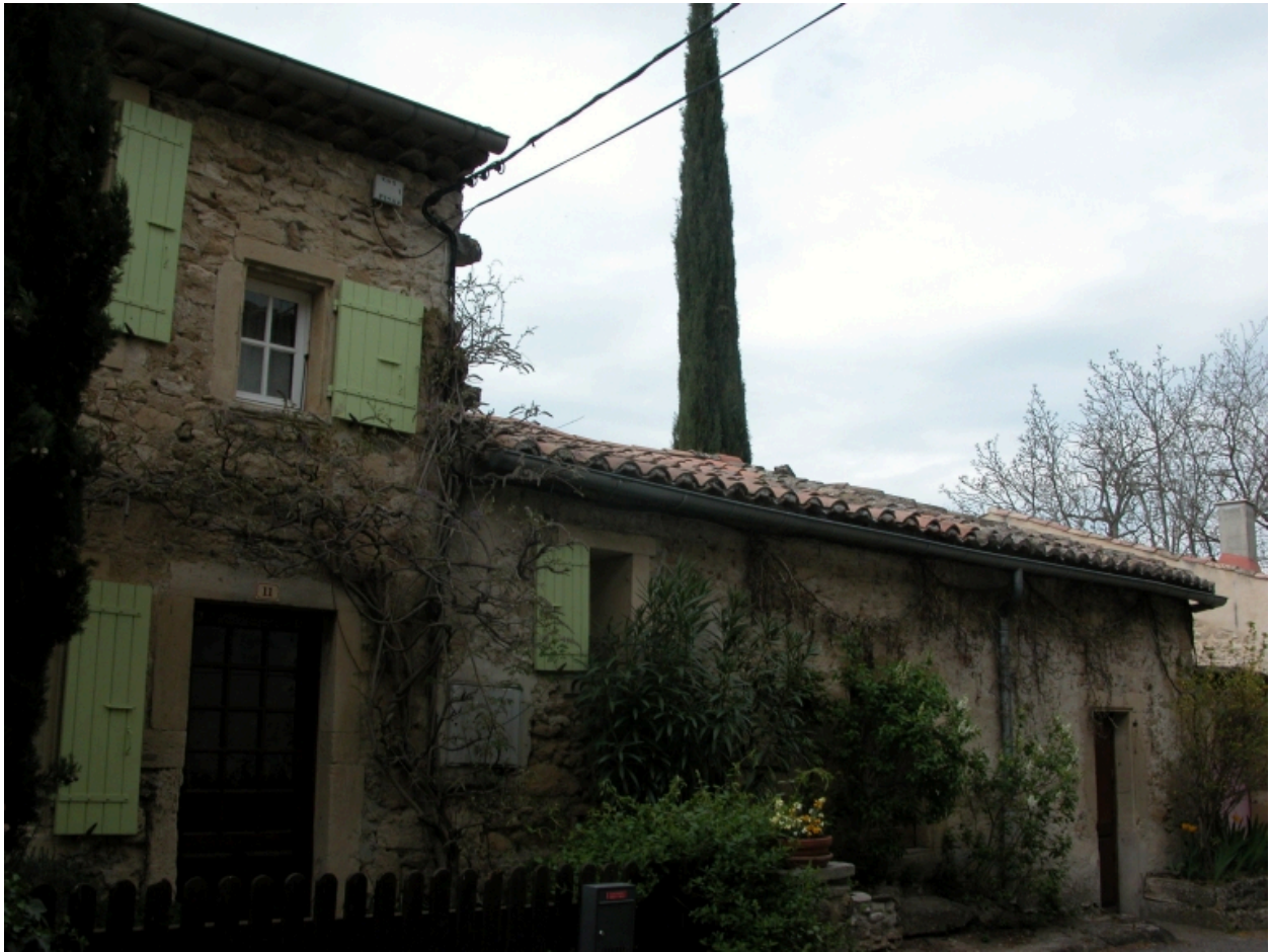
Village, 11 rue des Commerçants ; vue générale est de la maison et des dépendances.
