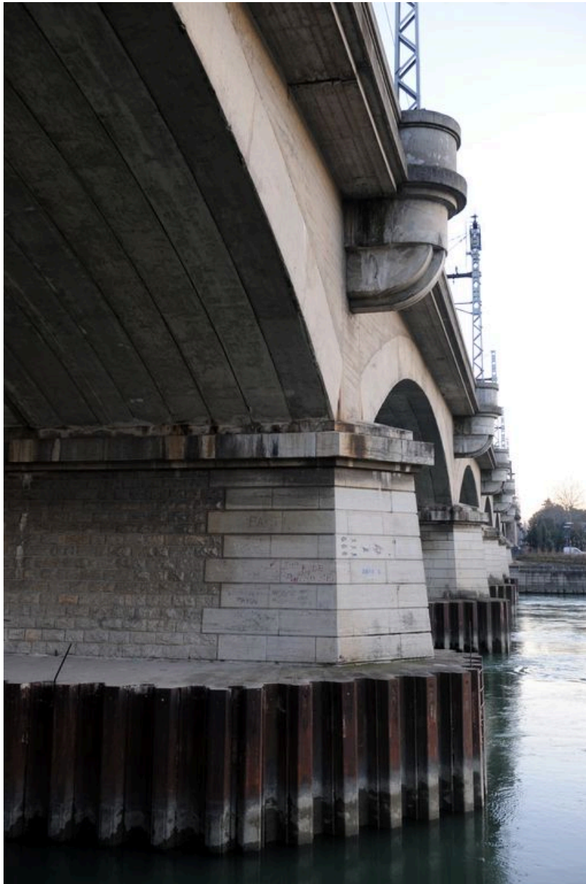
Vue partielle, de côté, face aval (depuis la rive droite)
