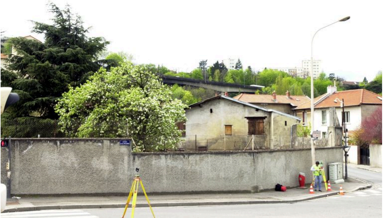
Vue de situation partielle depuis l'avenue Sidoine-Apollinaire
