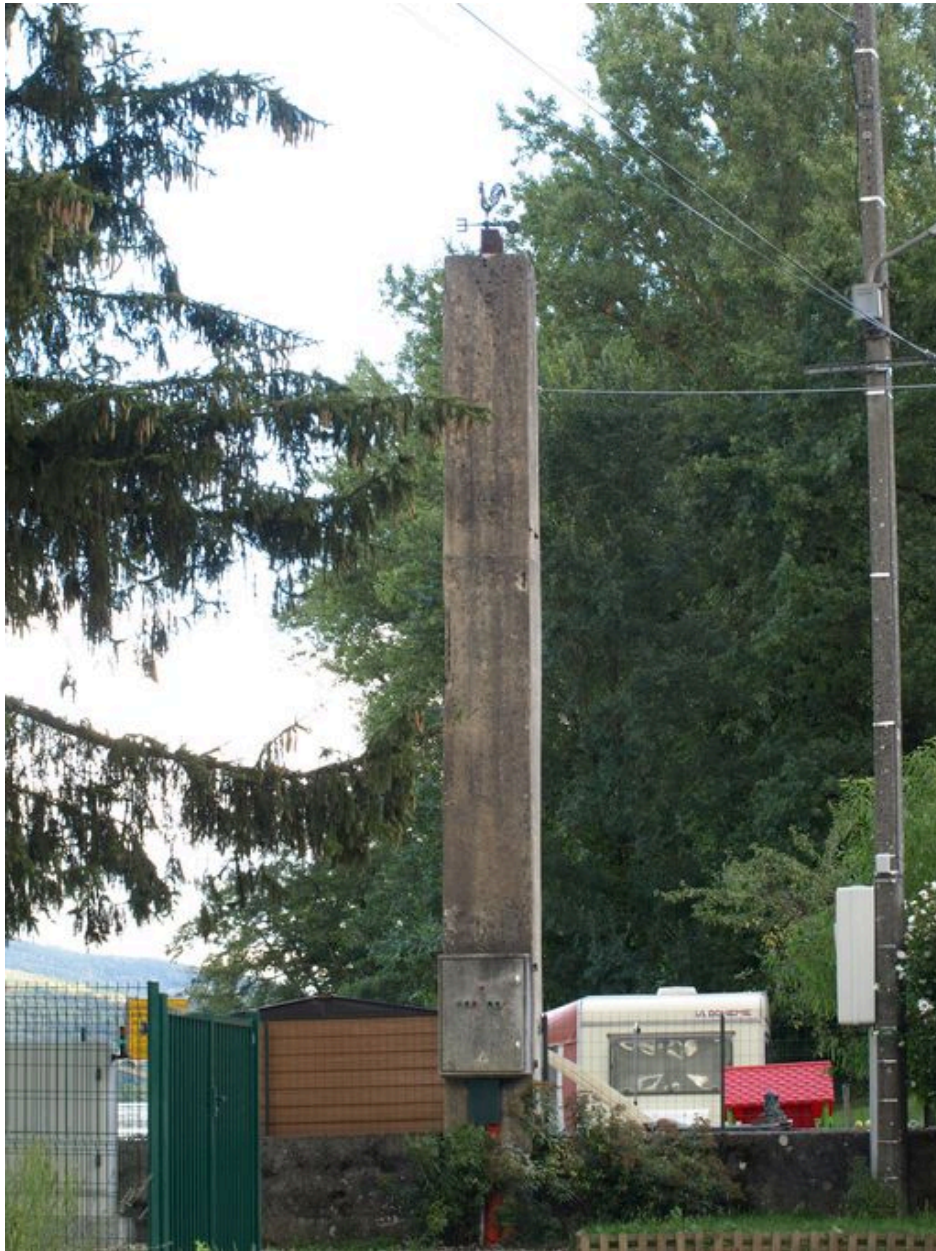
Pile, vue générale
