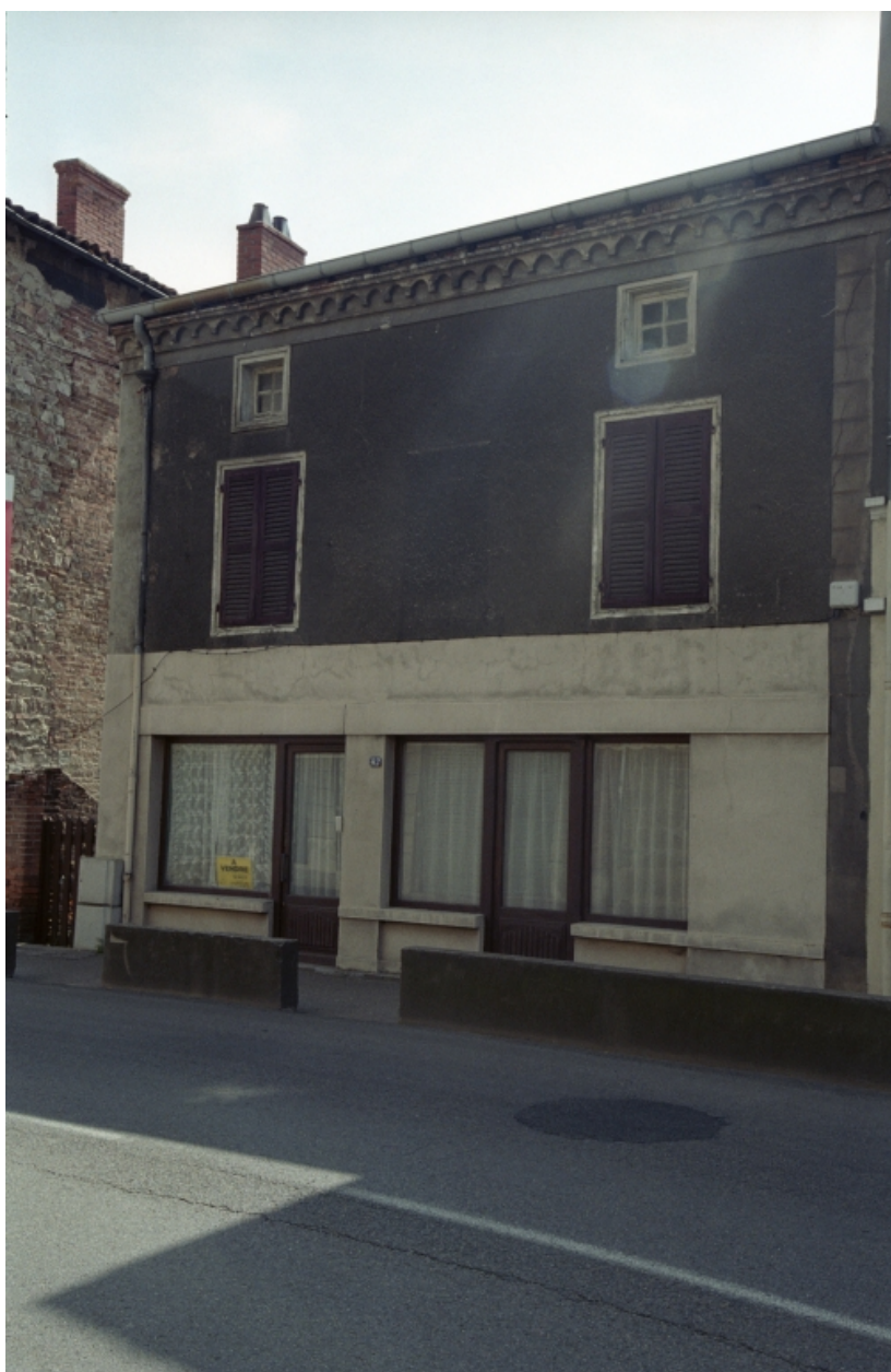
Boën, îlot 18, Lyon (rue de) 42. Vue générale de la façade sur rue.
