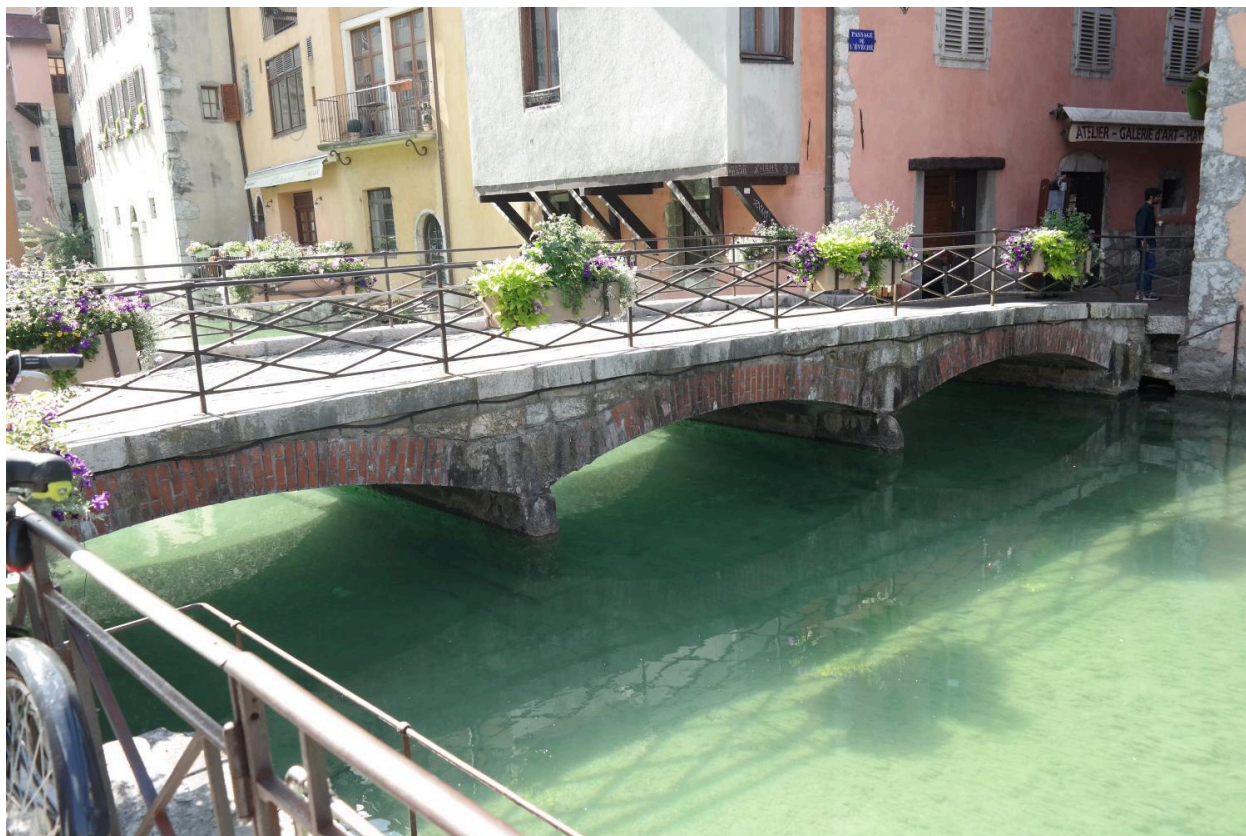
Pont du passage de l'Évêché, vue de la face aval
