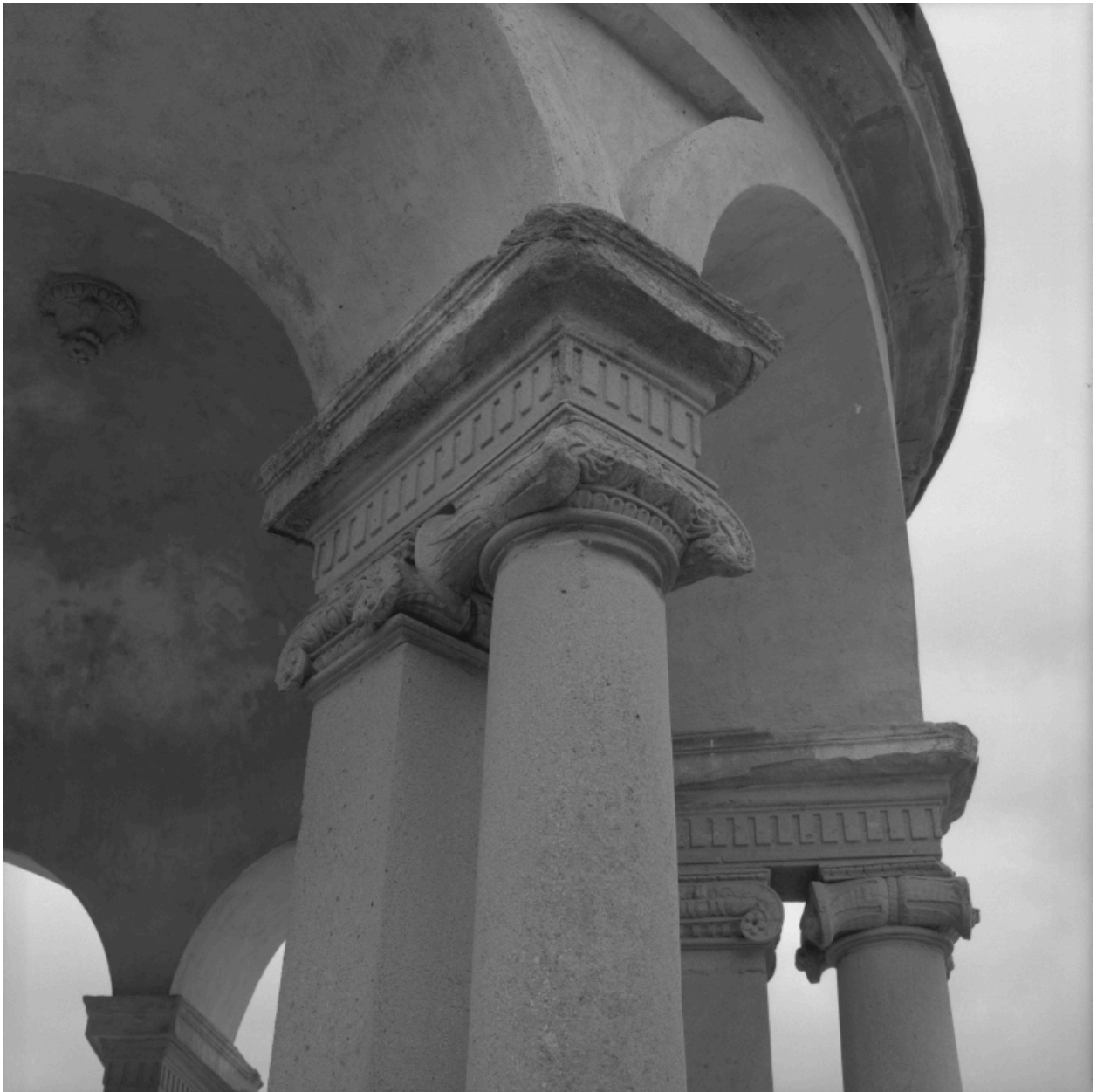
Détail de l'élévation.
