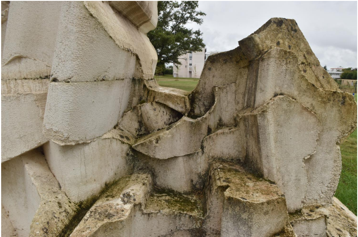
Détail des altérations : mousses, coulures
