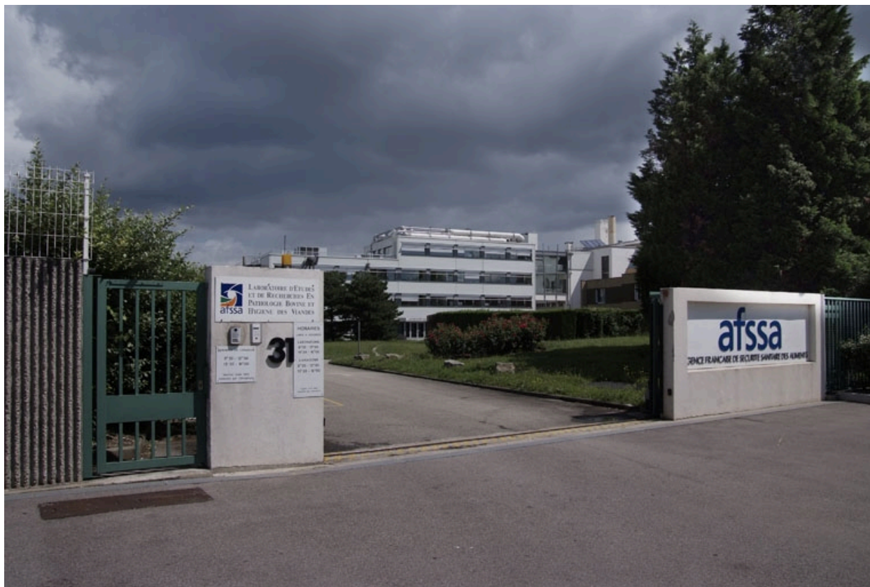
vue générale, 31-49 avenue Tony Garnier
