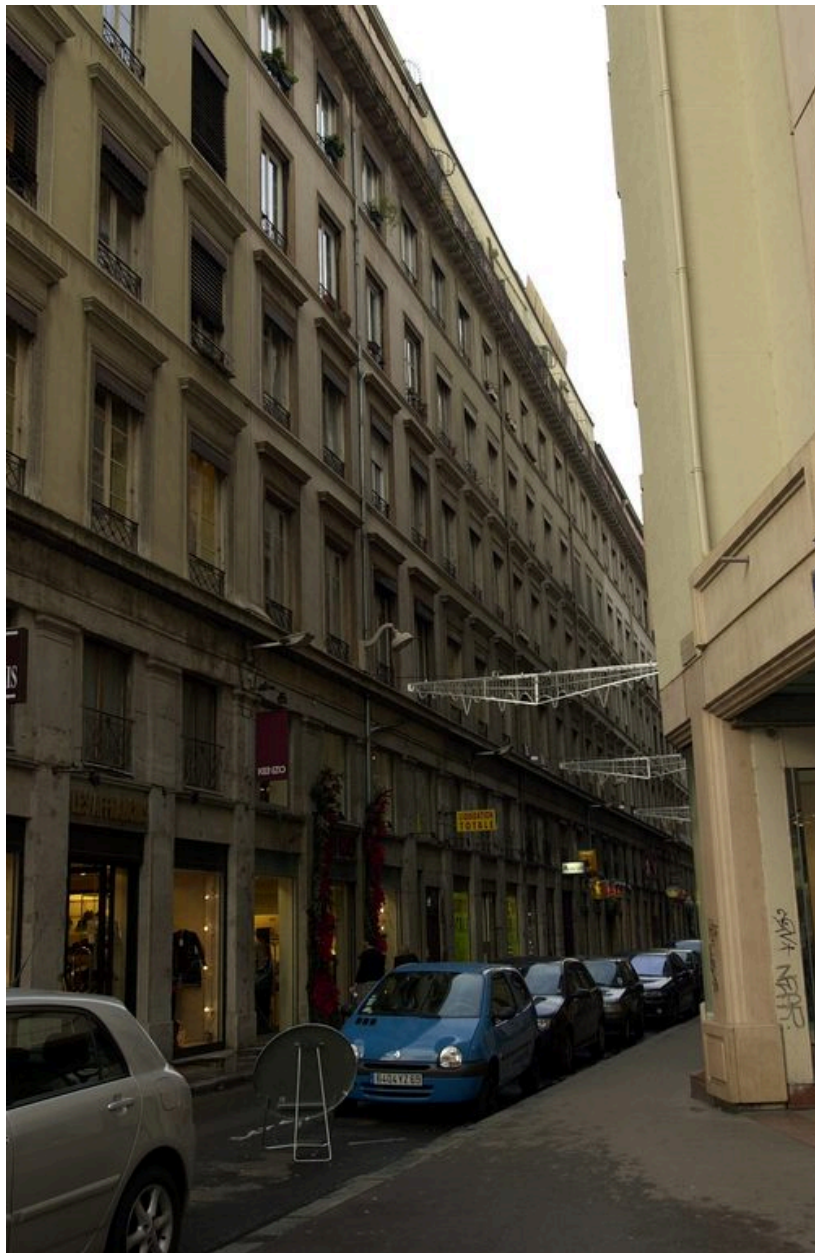
Vue générale depuis la rue Mercière
