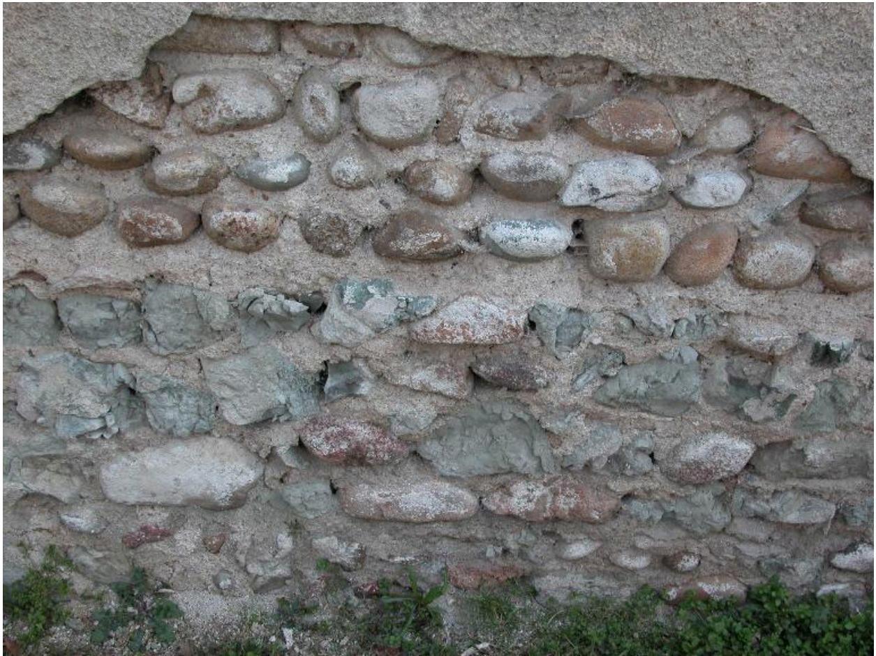
Bourg (le), Mur 1983 B1 79. Détail de mise en œuvre du mur de pisé sur un soubassement constitué de galets.
