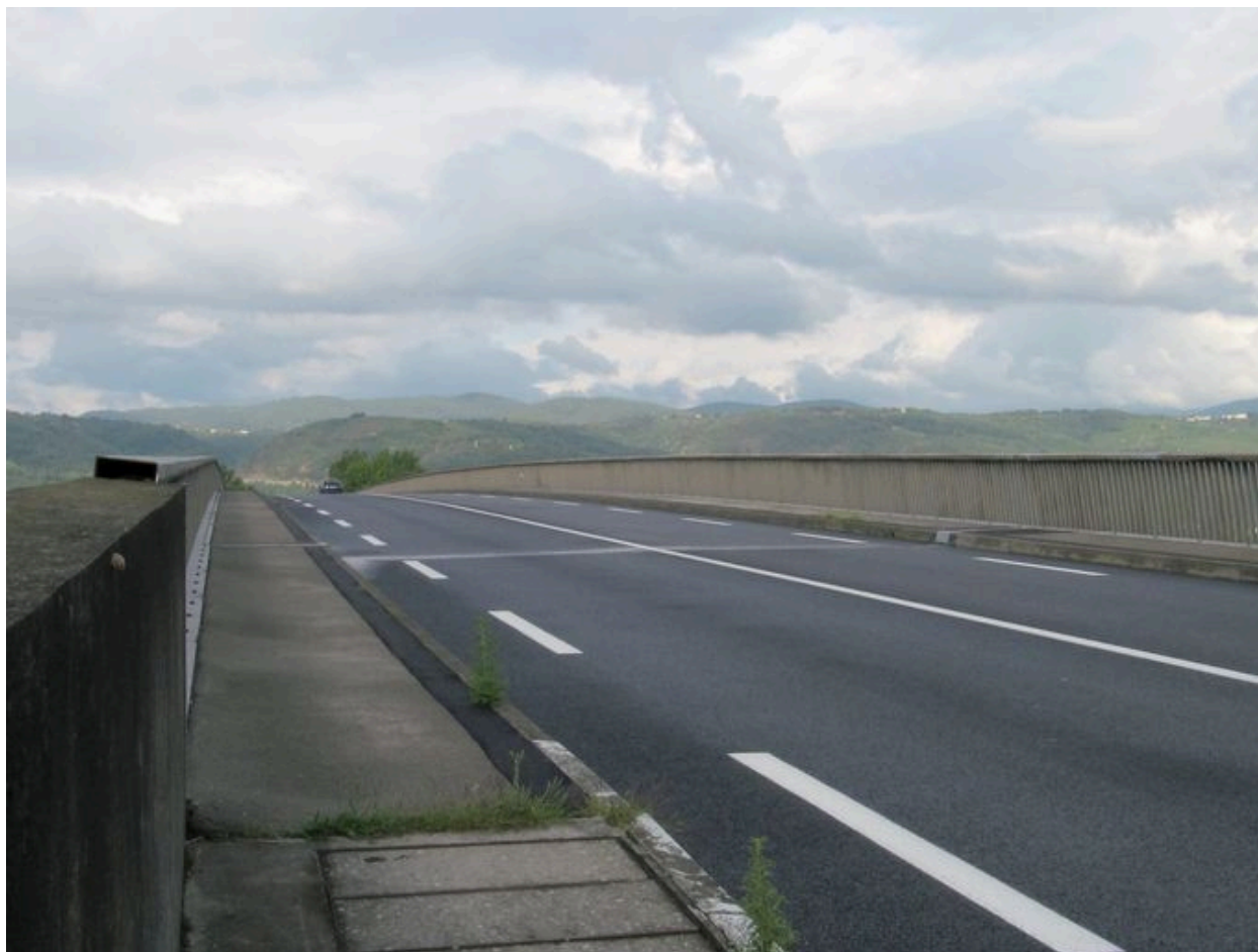
Chaussée (depuis la rive gauche)
