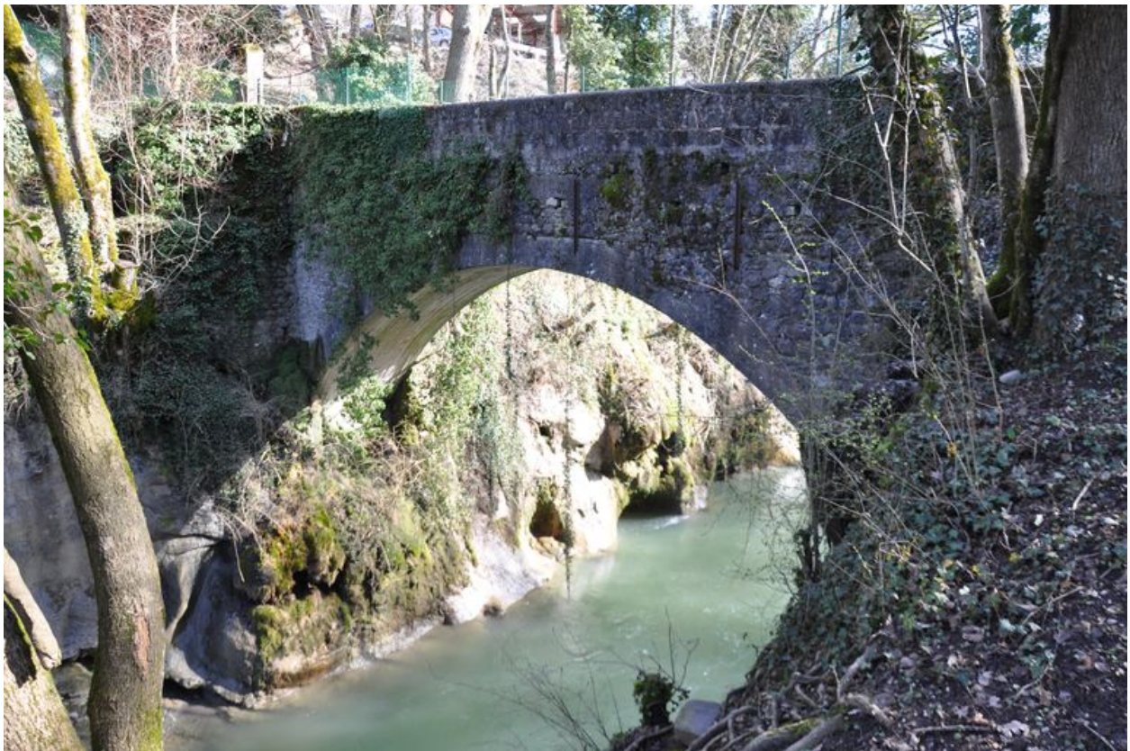
Vue du pont de la Bornalle prise côté rive gauche du torrent du Fier
