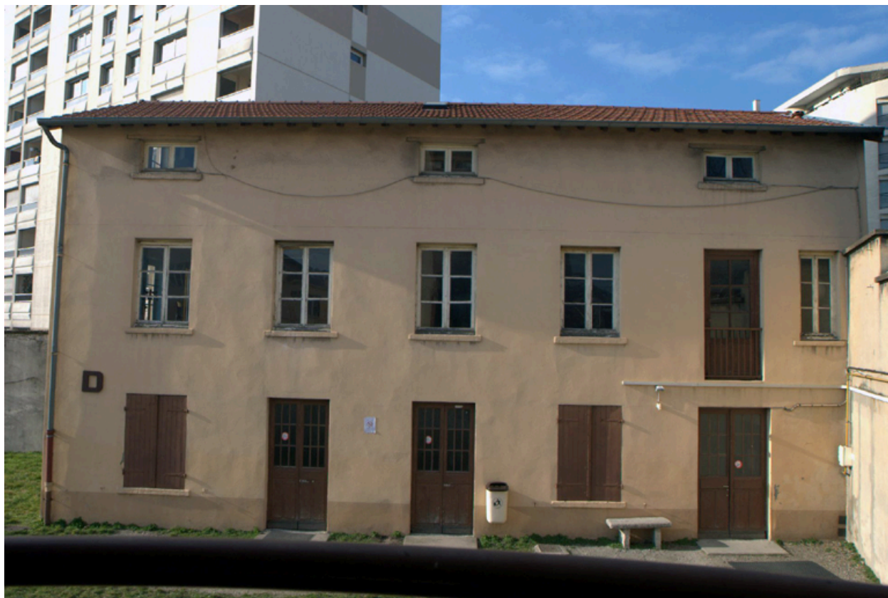
Le bâtiment D, élévation principale
