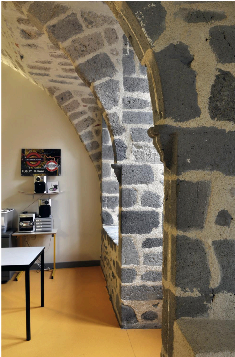
Foyer des élèves : détail des piliers et voûains
