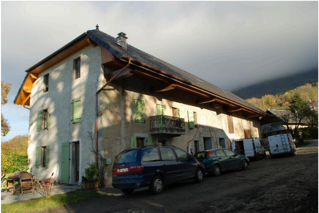
Vue d'ensemble de trois-quarts depuis le sud-ouest.
