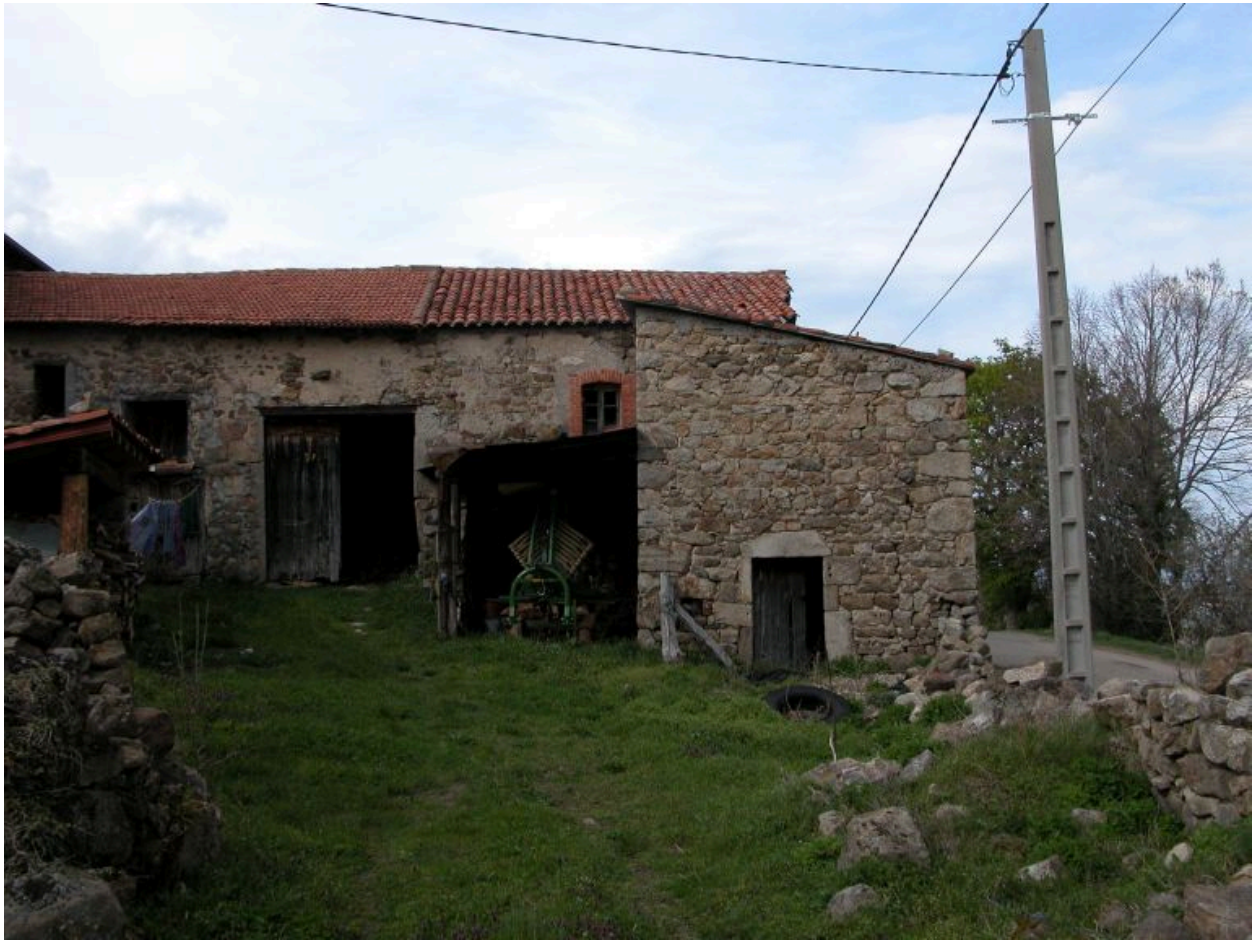
Vue de la grange-étable nord, du logis 4 et de la petite étable, depuis le sud.
