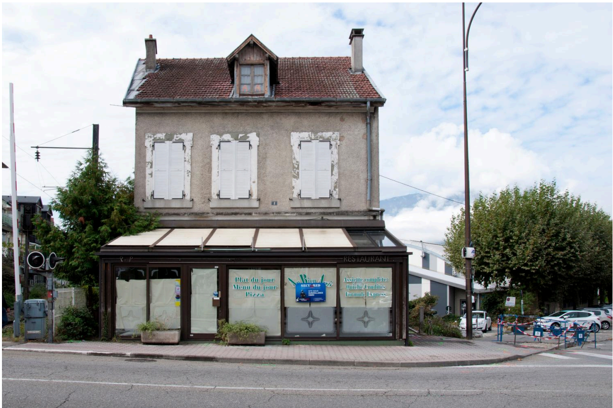
Façade antérieure, avenue du Grand-Port
