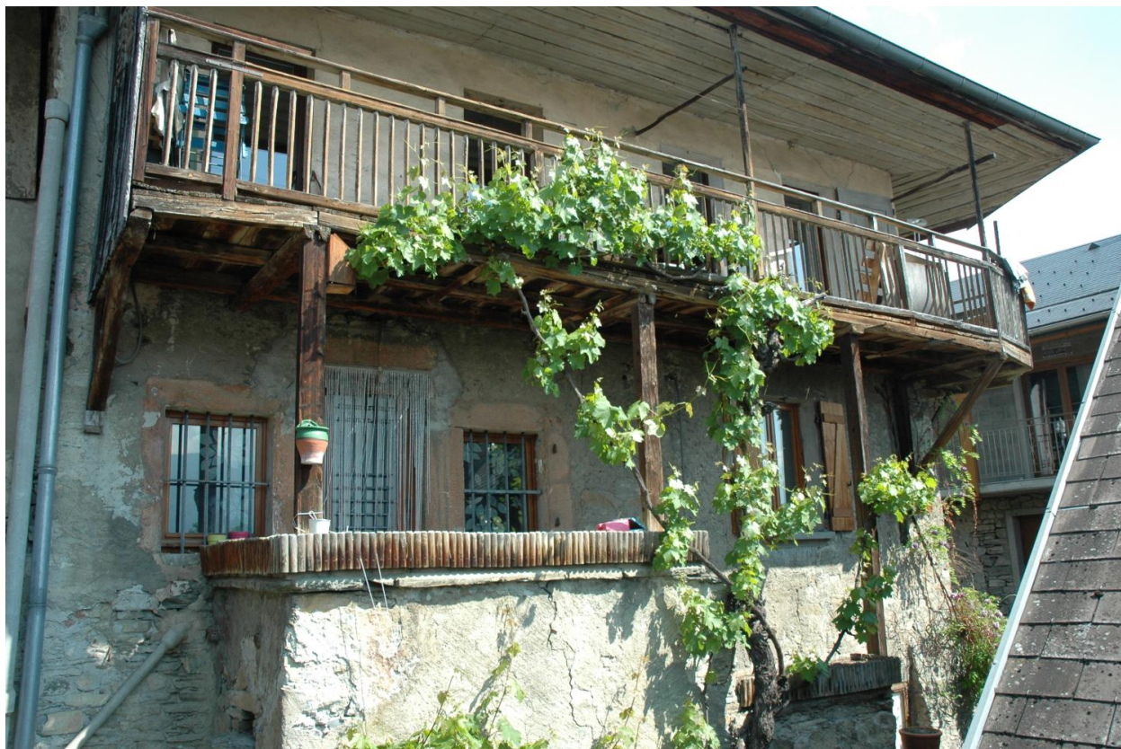
Maisons de vigneron (2018 C2 1221). Vue sud.
