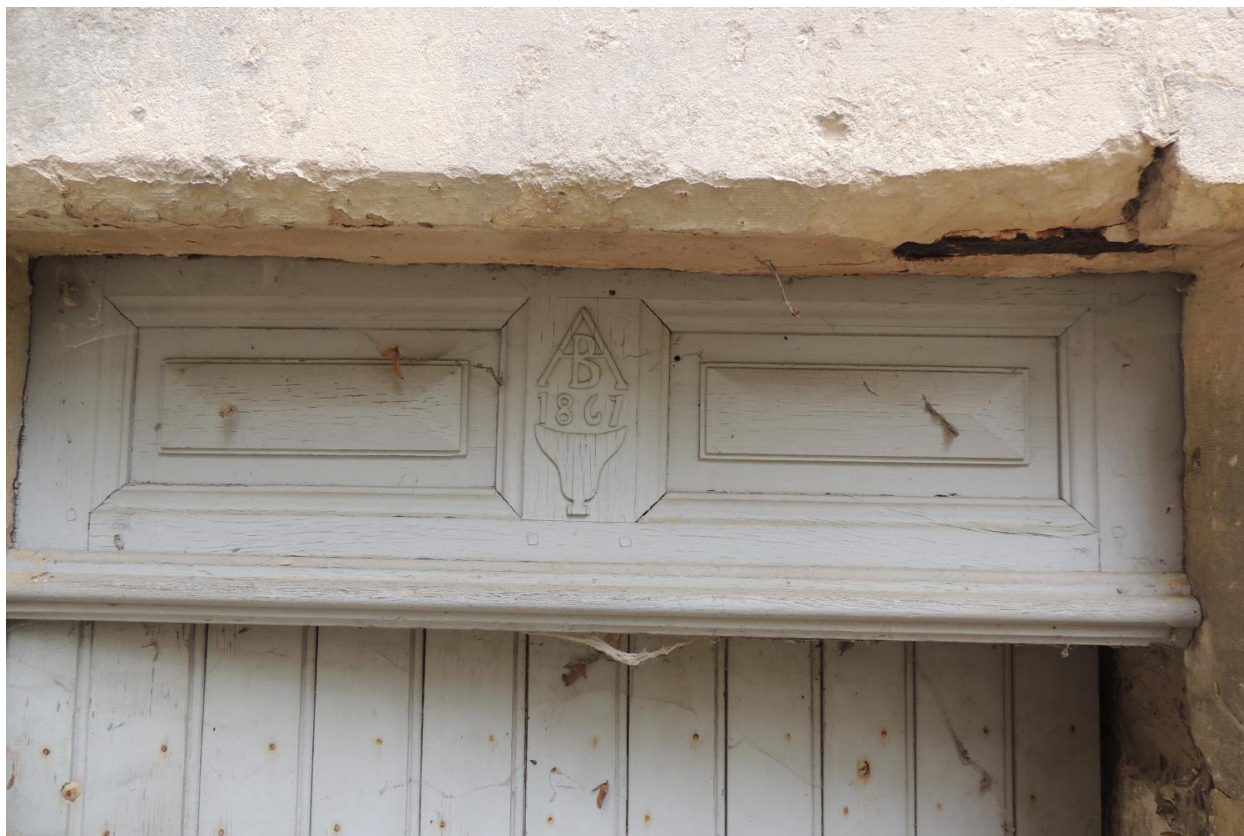
Façade sud, entrée des communs : linteau sculpté avec date.
