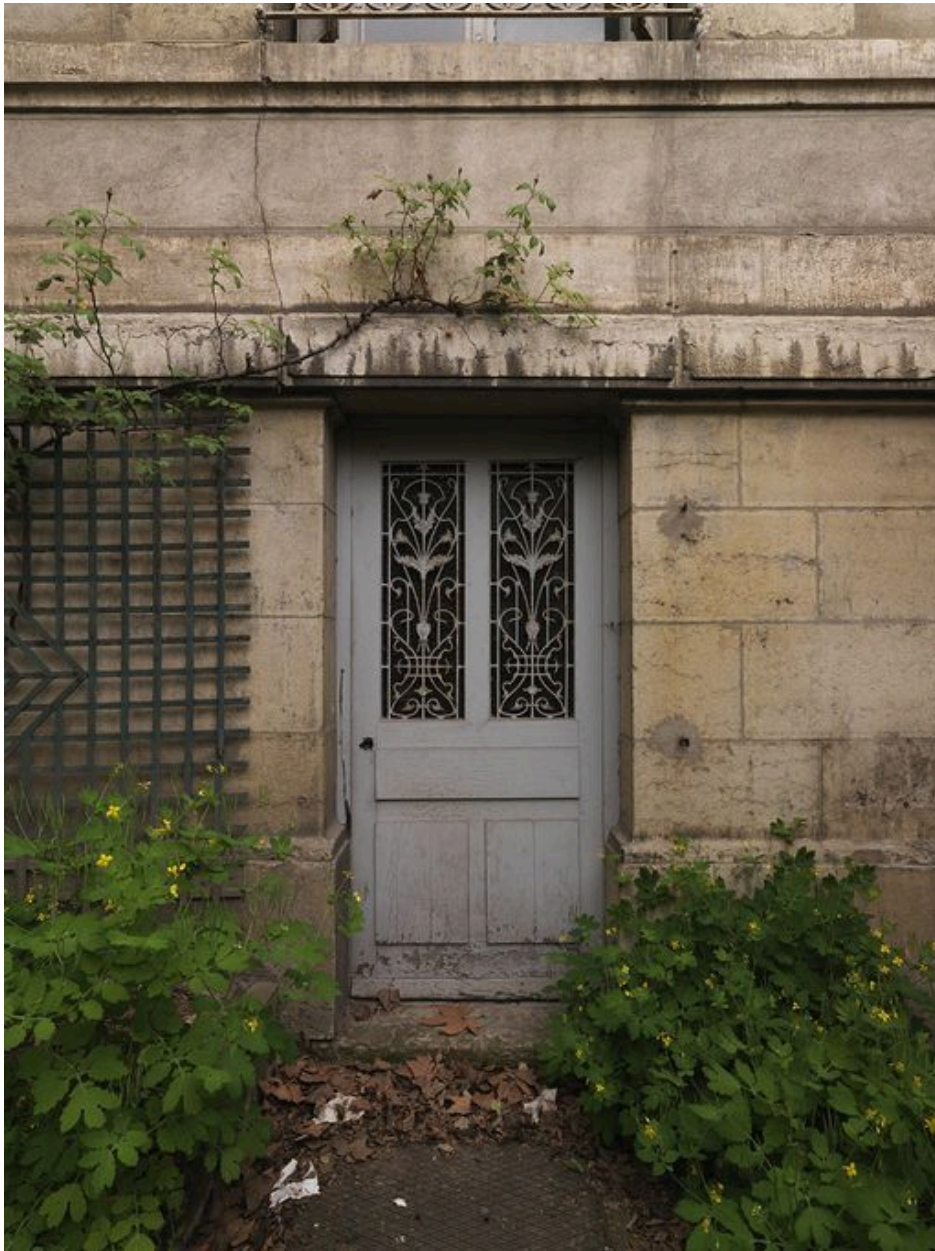
Détail, depuis la cour principale, de la porte de la cave de la directrice, située dans le soubassement du bâtiment ouest.
