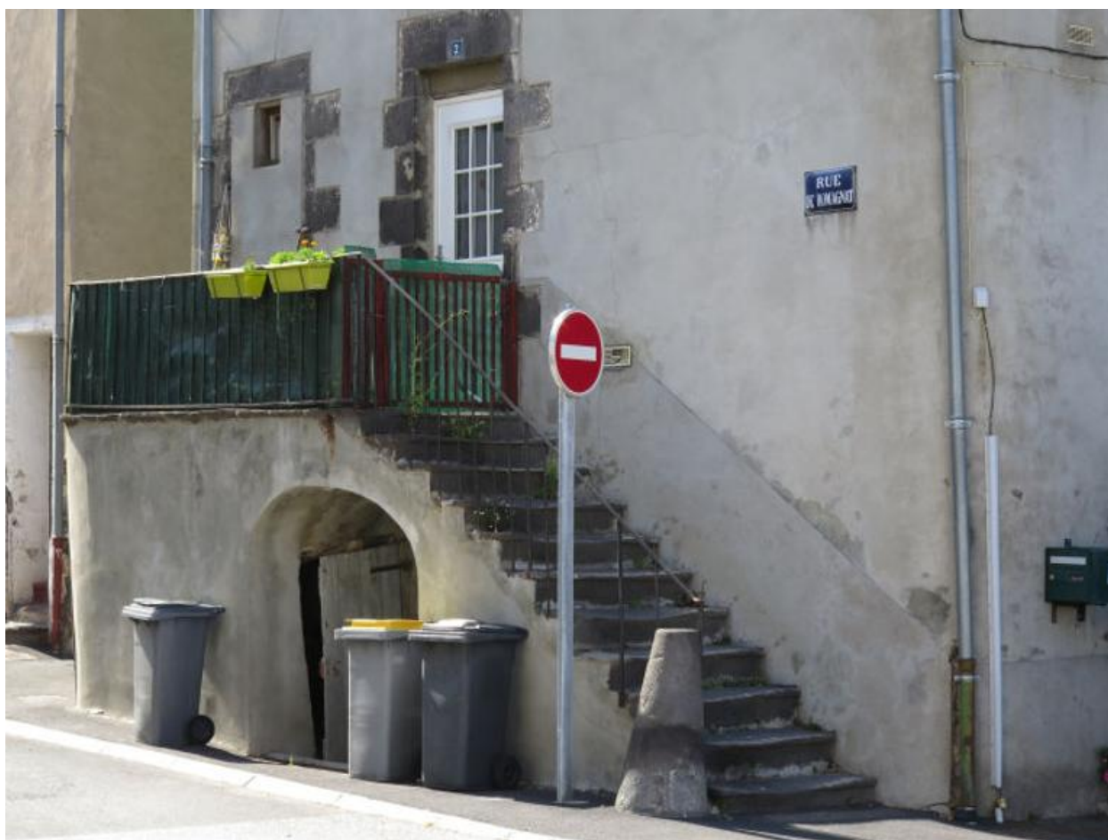
Vue partielle de la façade principale
