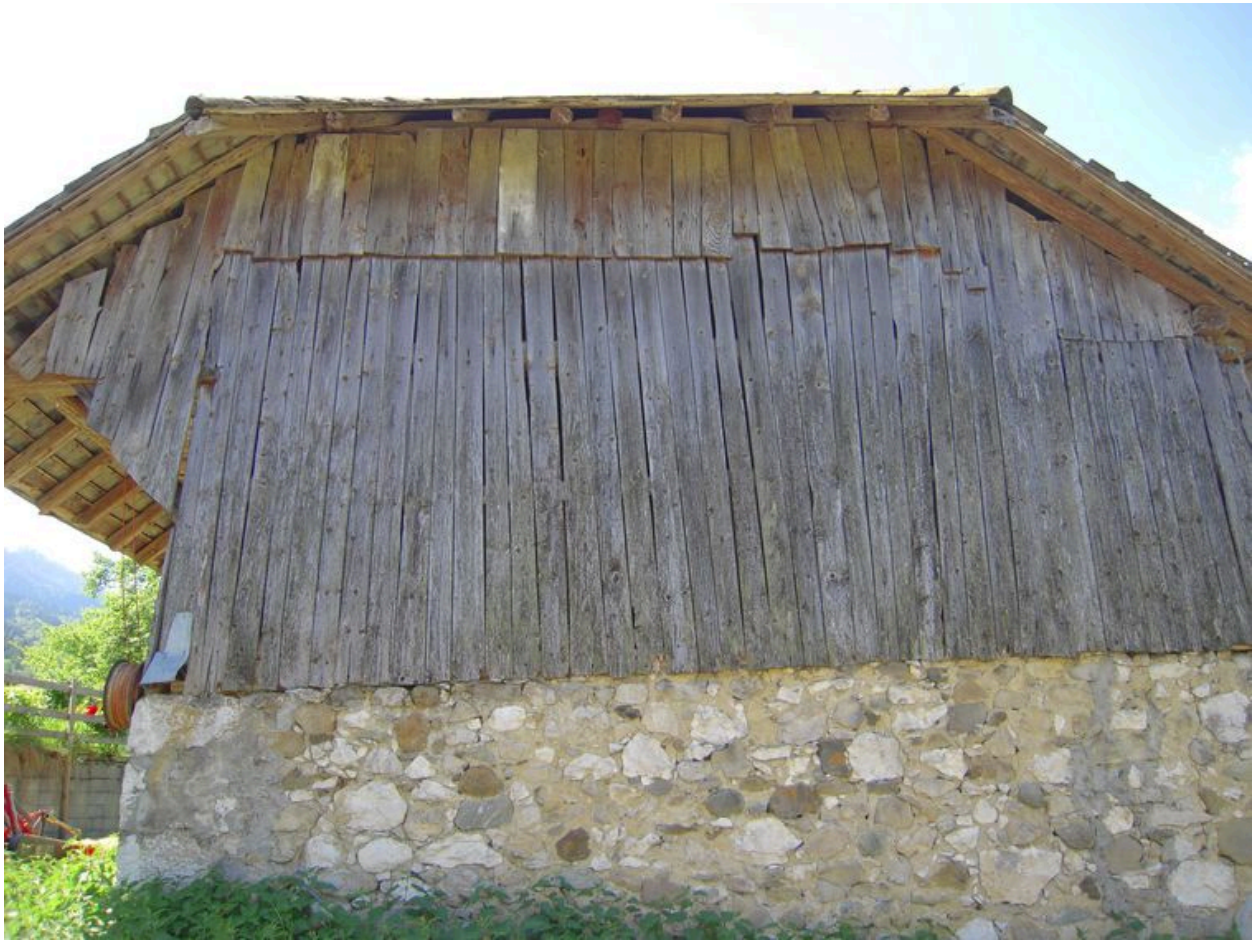
Vue de la façade nord.
