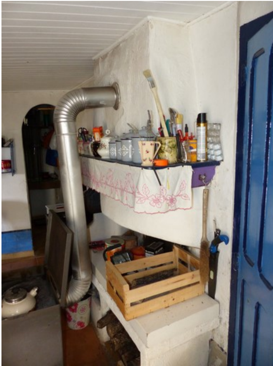
Rez-de-chaussée surélevé, cuisine. Mur est, cheminée.
