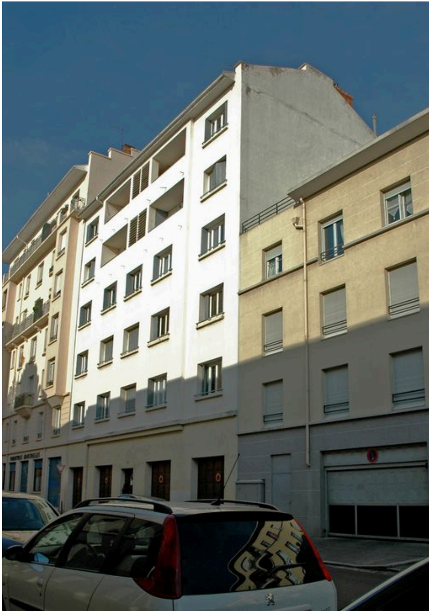
Elévation principale depuis le sud-est
