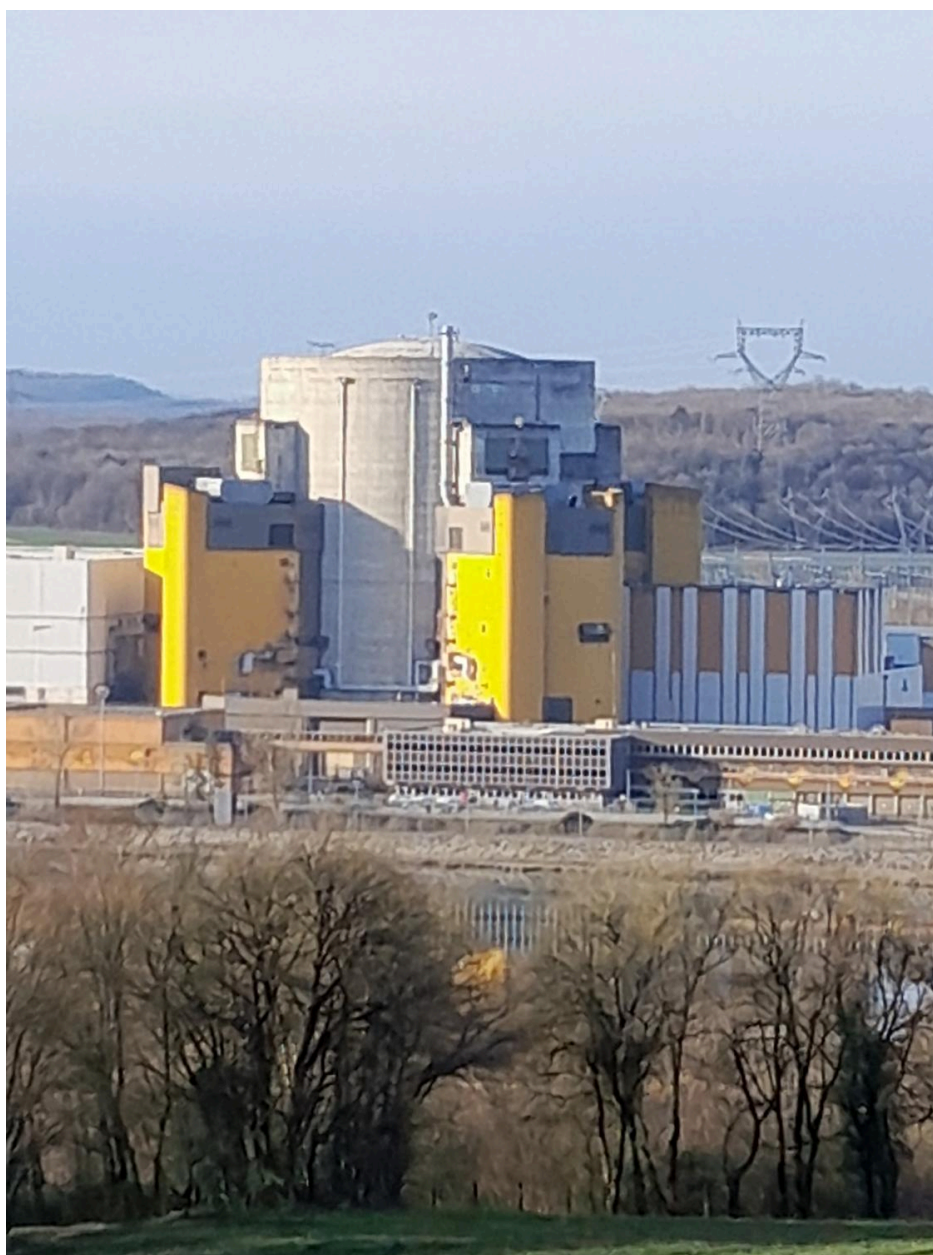
Centrale nucléaire de Creys-Malville
