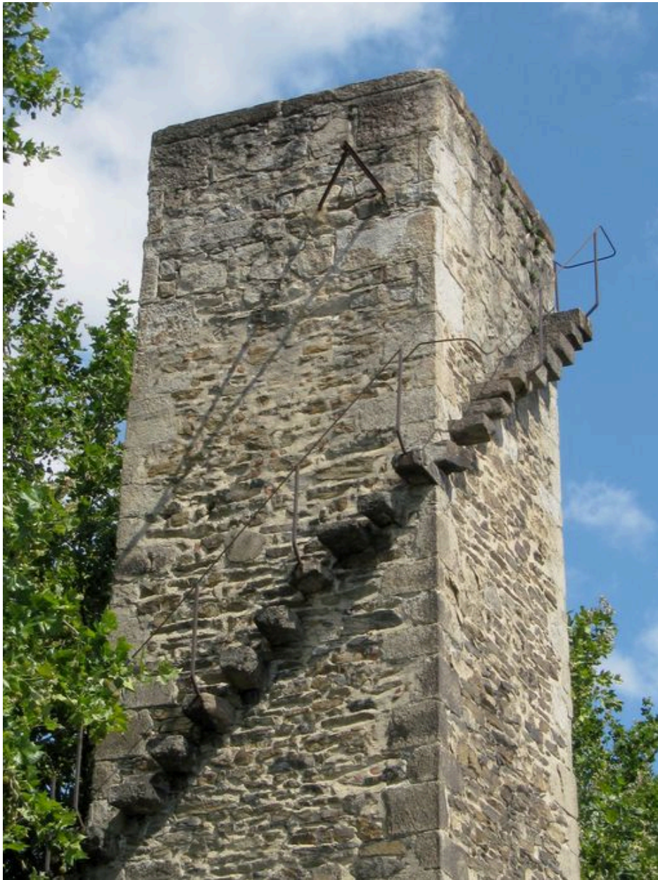
Vue partielle, sommet (depuis le sud-est)
