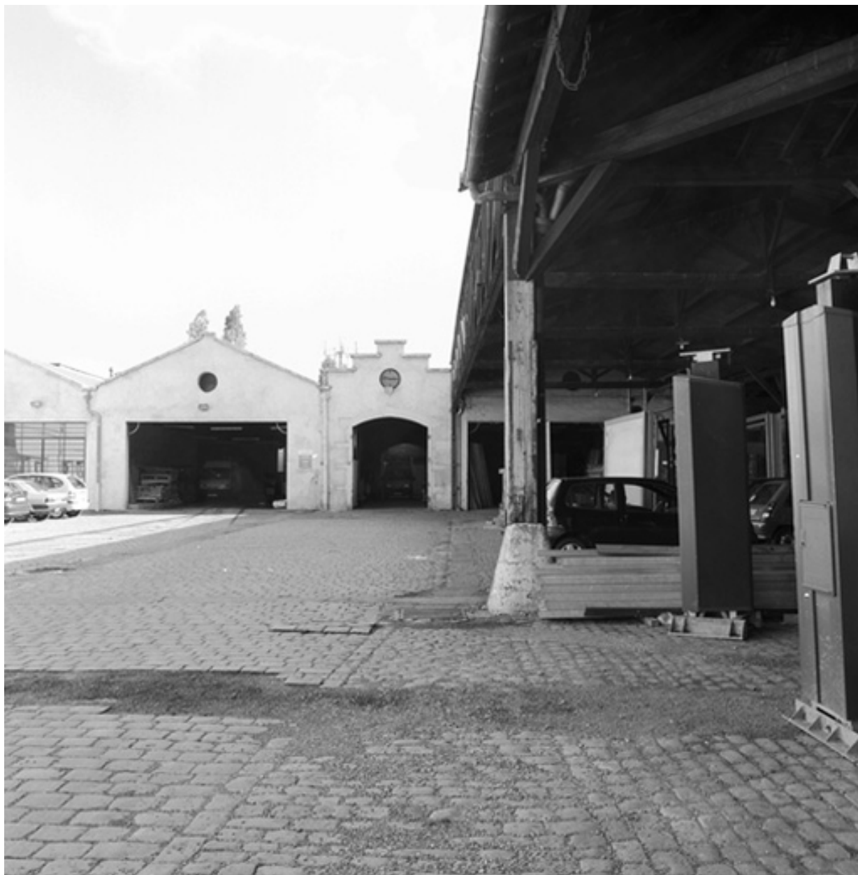
Vue générale ouest, fronton des ateliers et cour pavée
