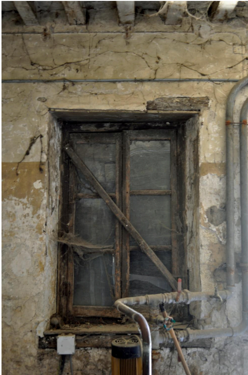
Détail de menuiserie de fenêtre
