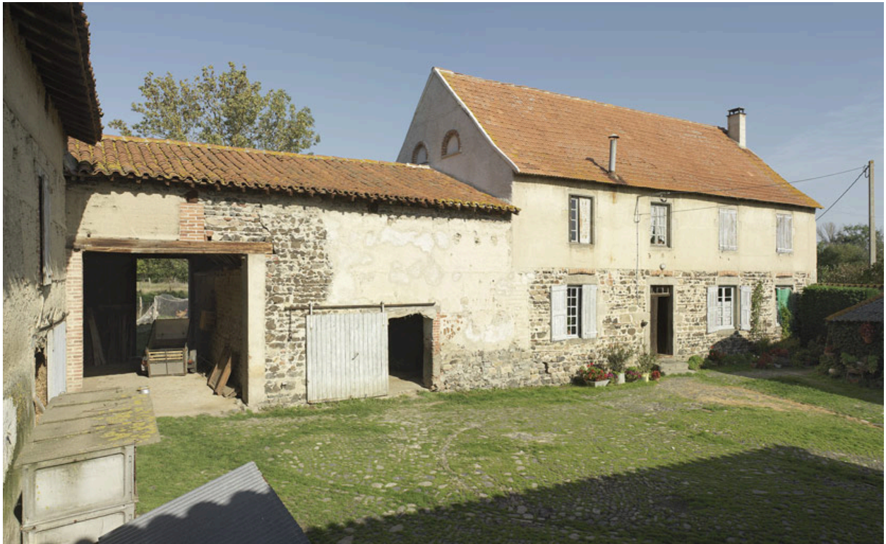
Vue d'ensemble du logis, de l'étable à boeufs et de la grange-remise-cuvage.
