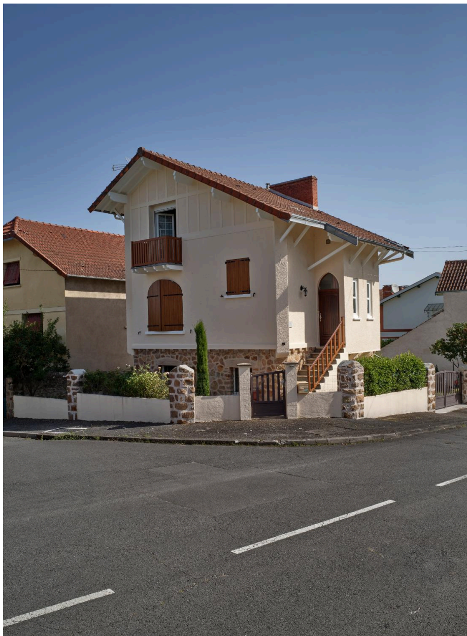
Façade de la maison du 12 rue Massenet.
