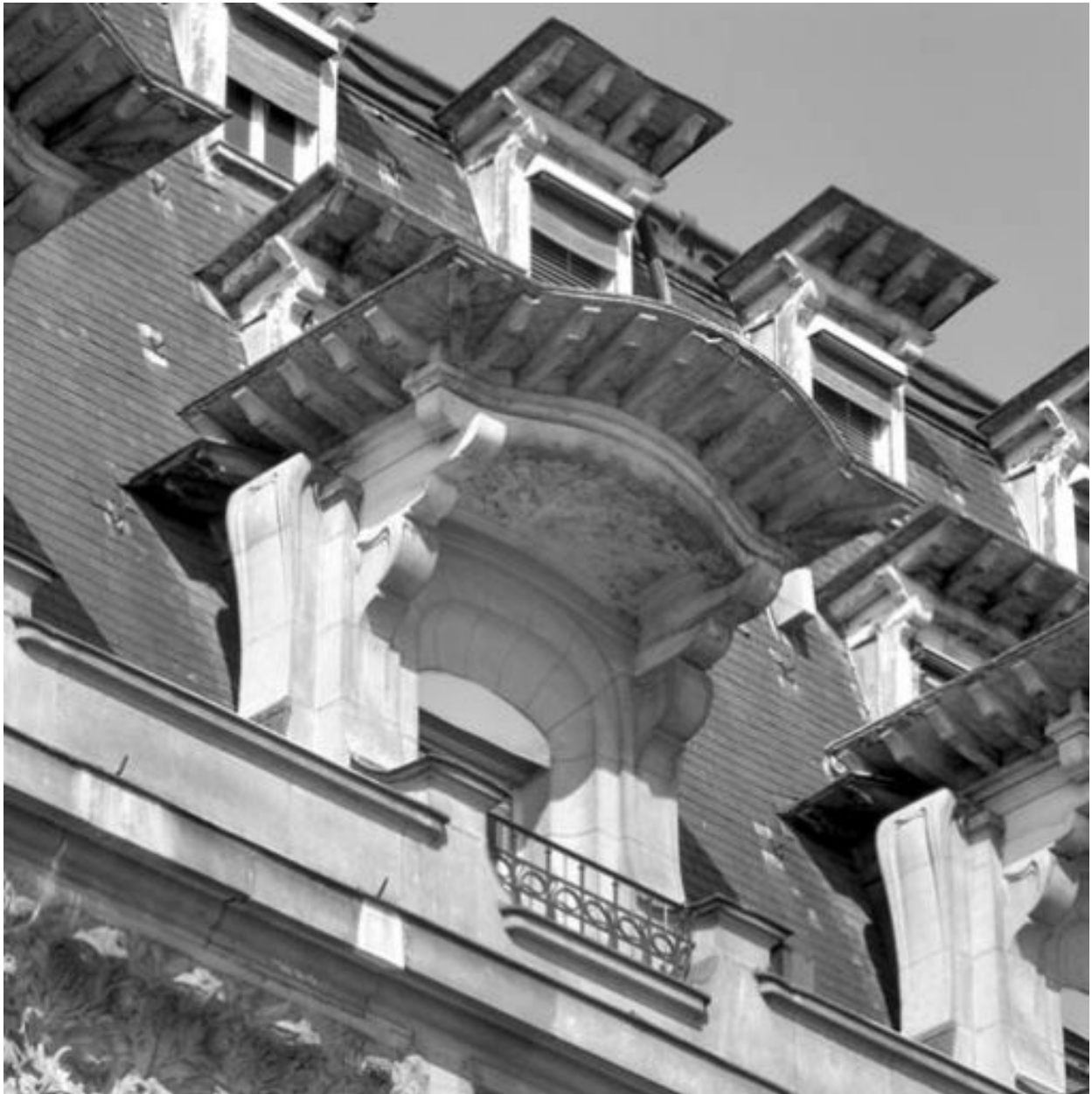
Détail serré des lucarnes des trois étages de comble
