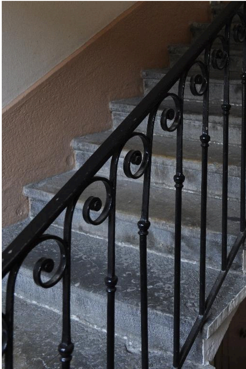
Détail du garde-corps de l'escalier
