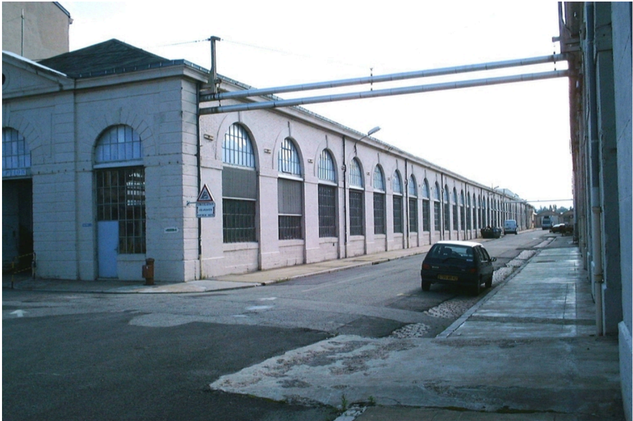
Vue des bâtiments du site de Giat industrie de Saint Etienne
