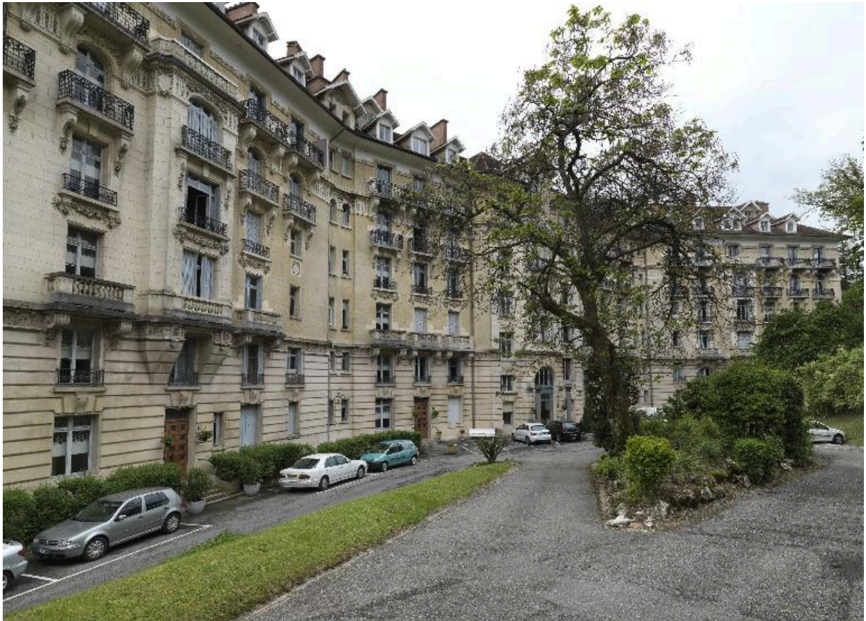
Façade sur cour: vue d'ensemble
