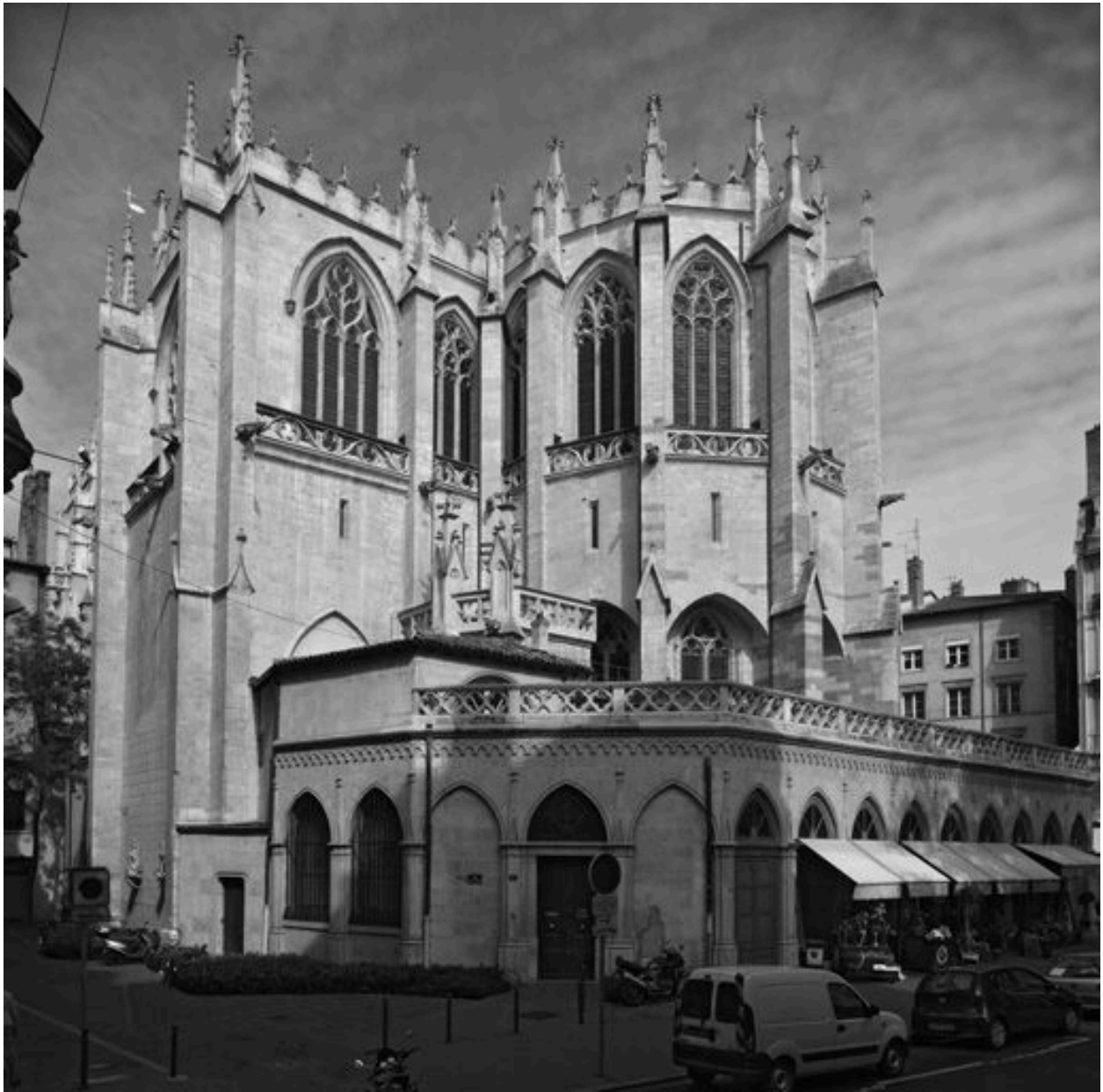
Chevet, sacristies et boutiques, vue générale côté sud
