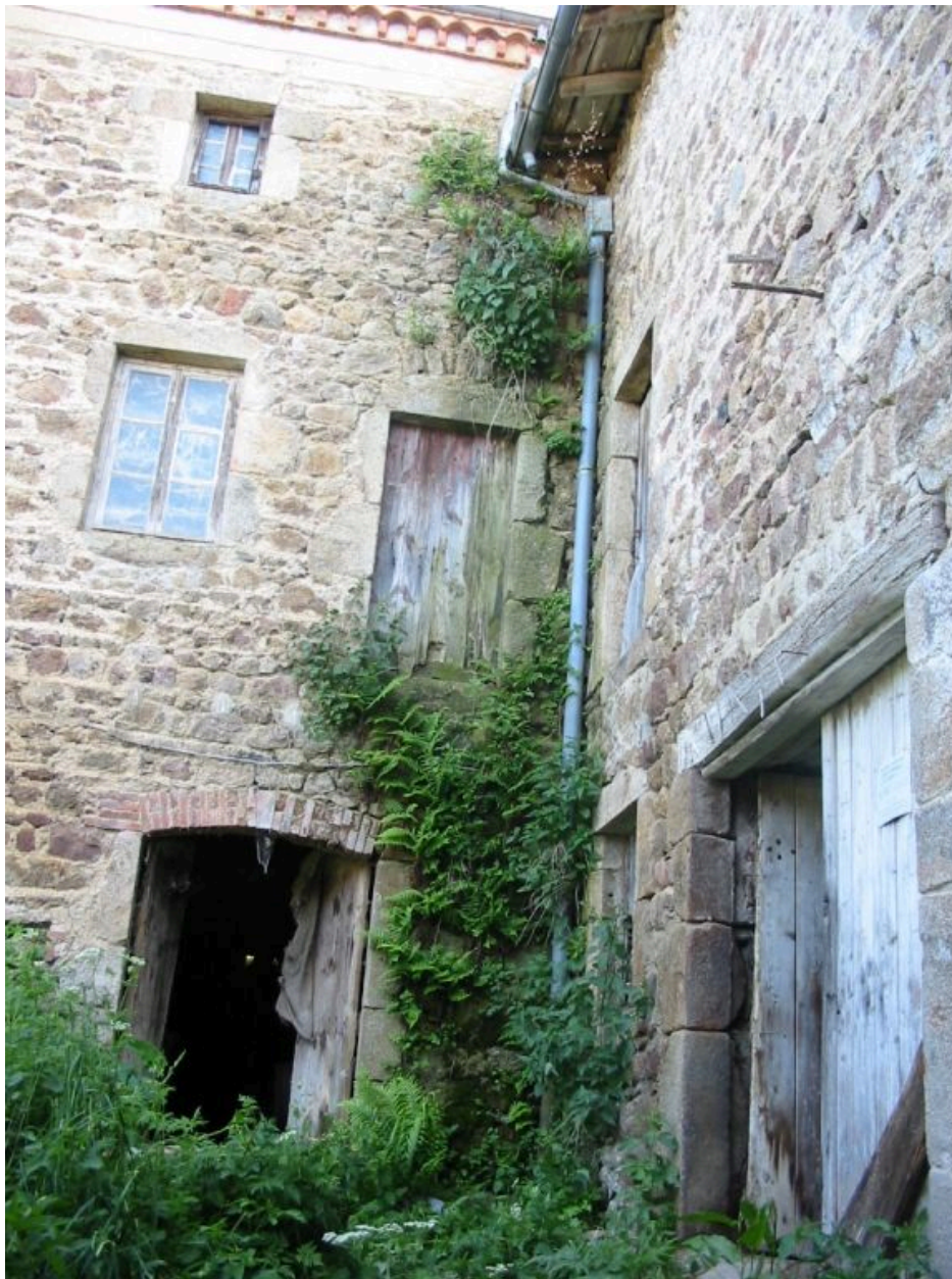
Angle intérieur du logis et de la grange-étable
