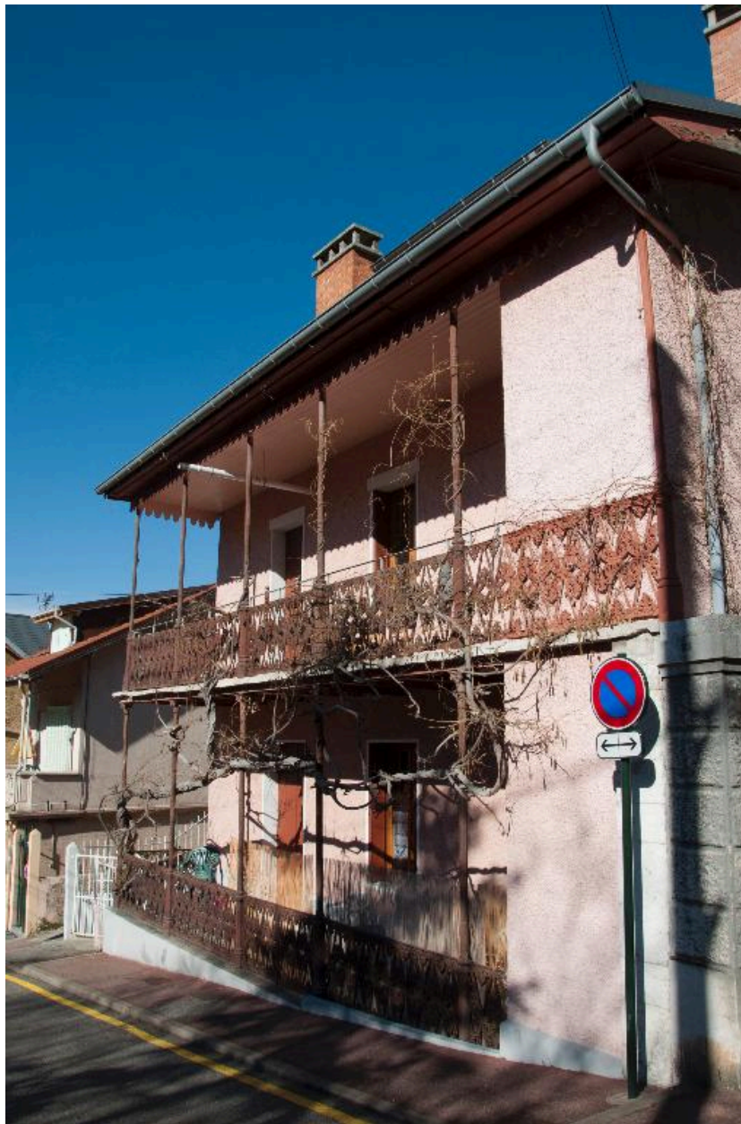
Les Glycines, 11 rue du bain Henri IV (parcelle BZ 132) : façade sud
