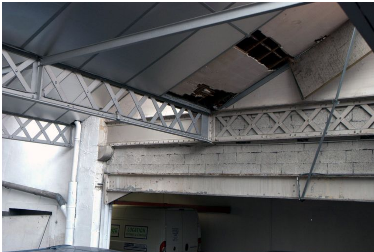
Détail de la charpente métallique du parc de stationnement
