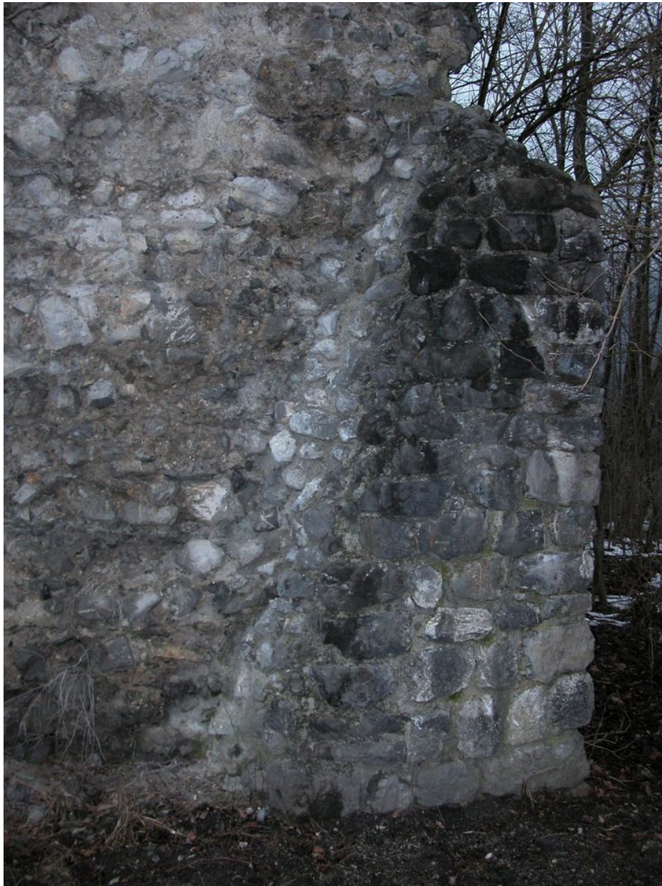
Détail d'un renfort d'angle
