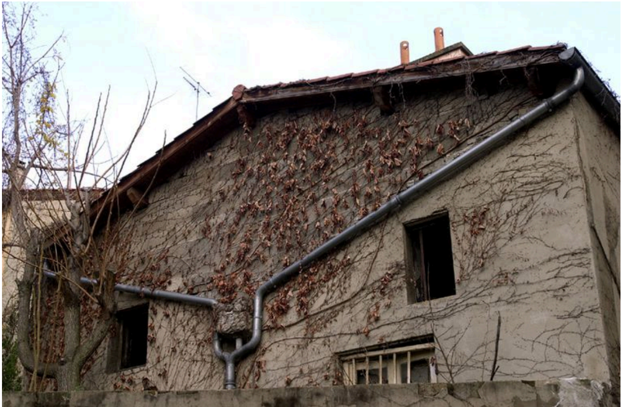
Elévation postérieure du 96
