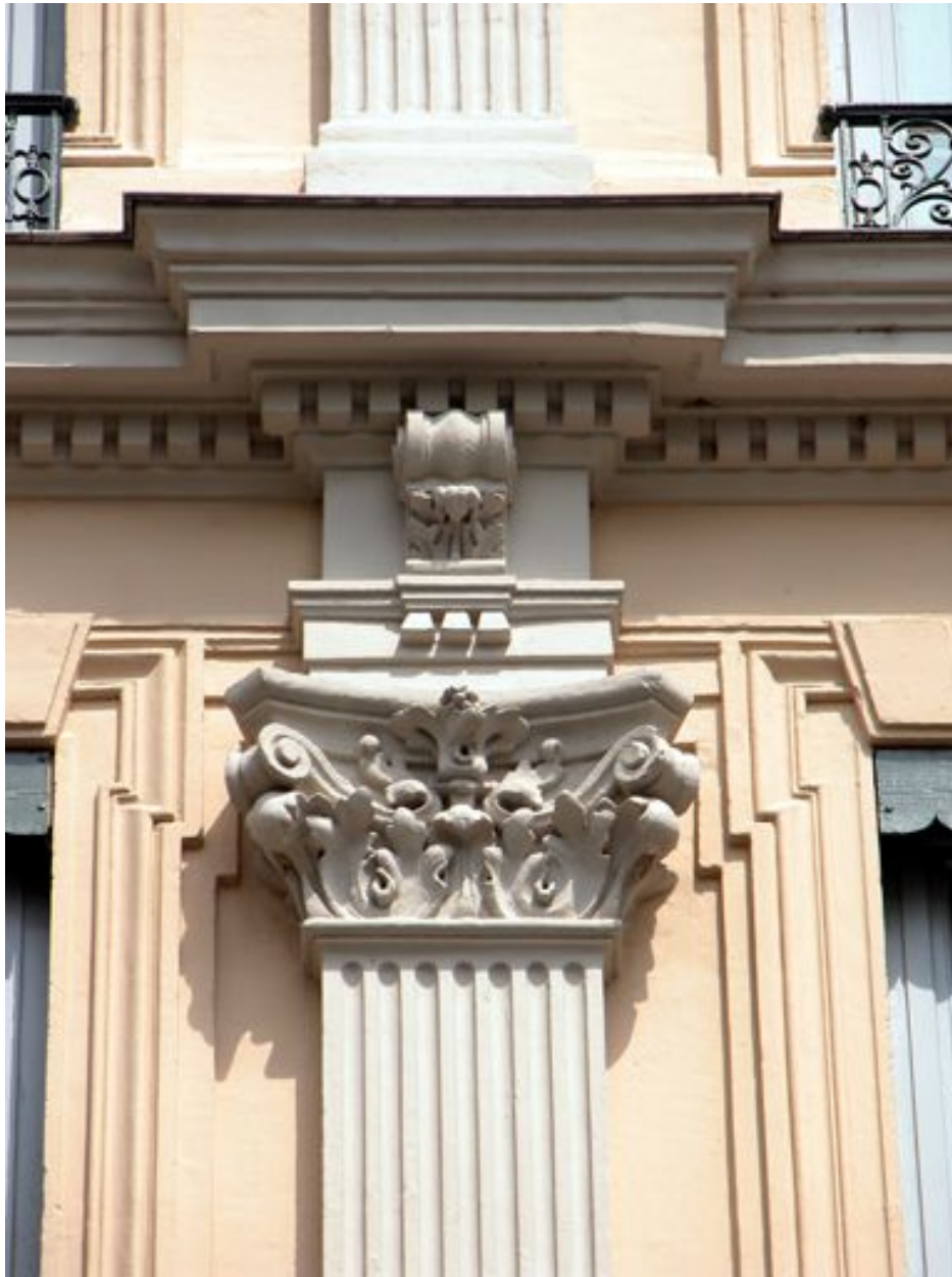
Façade sur le quai, partie centrale, 4e niveau, chapiteau de l'ordre colossal
