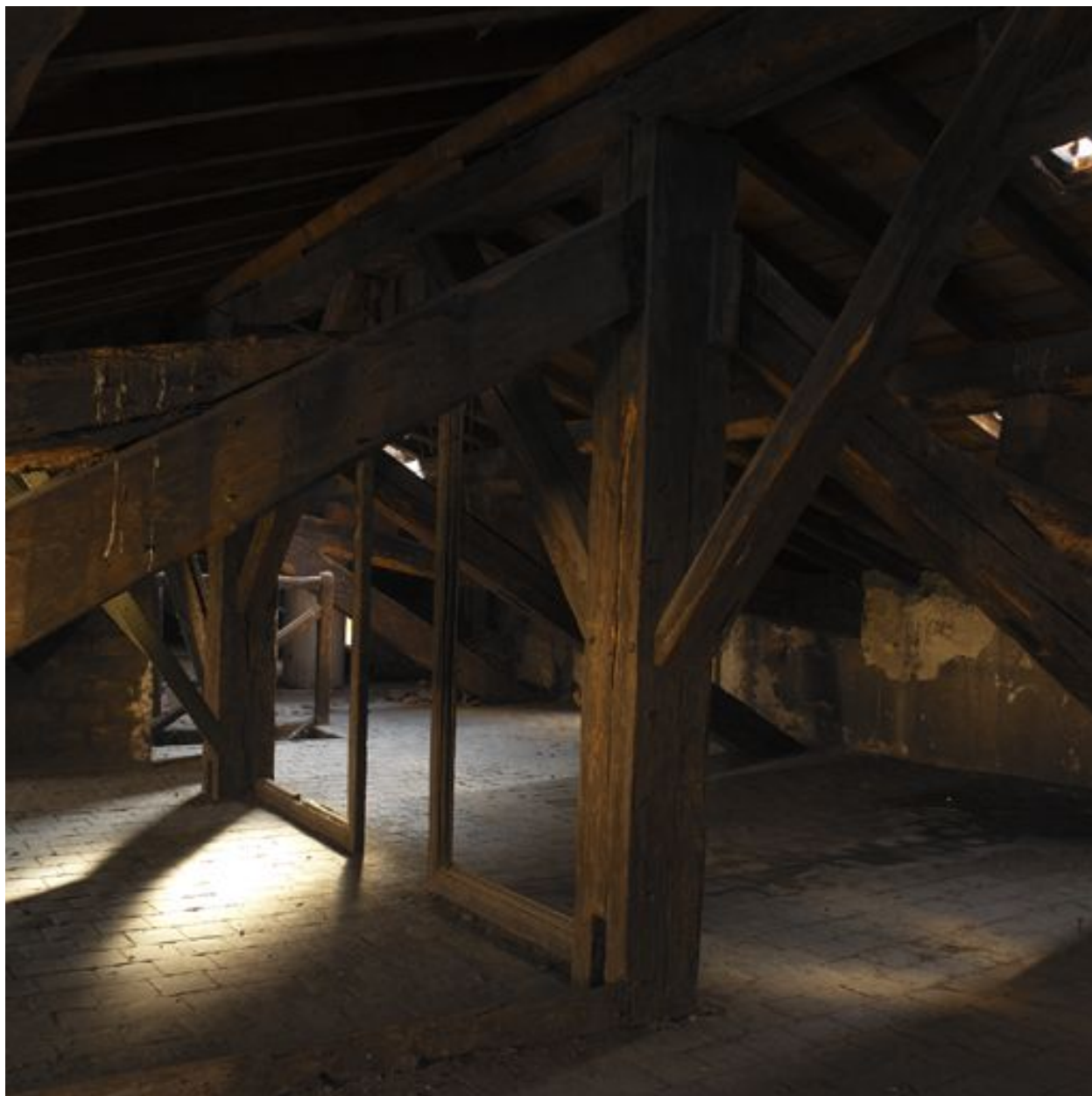
La charpente du corps de bâtiment ouest
