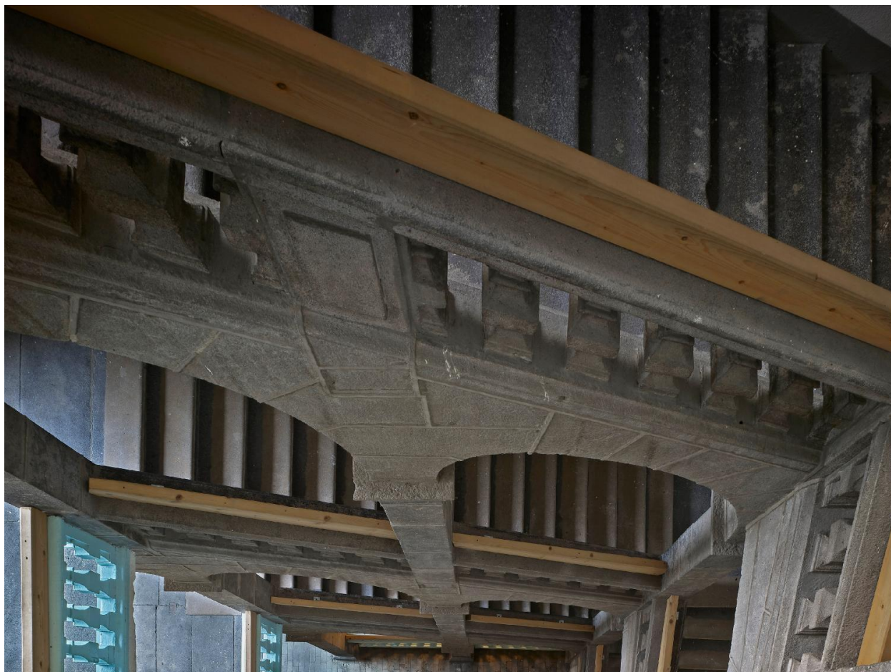
Escalier F : vue de la cage depuis le haut
