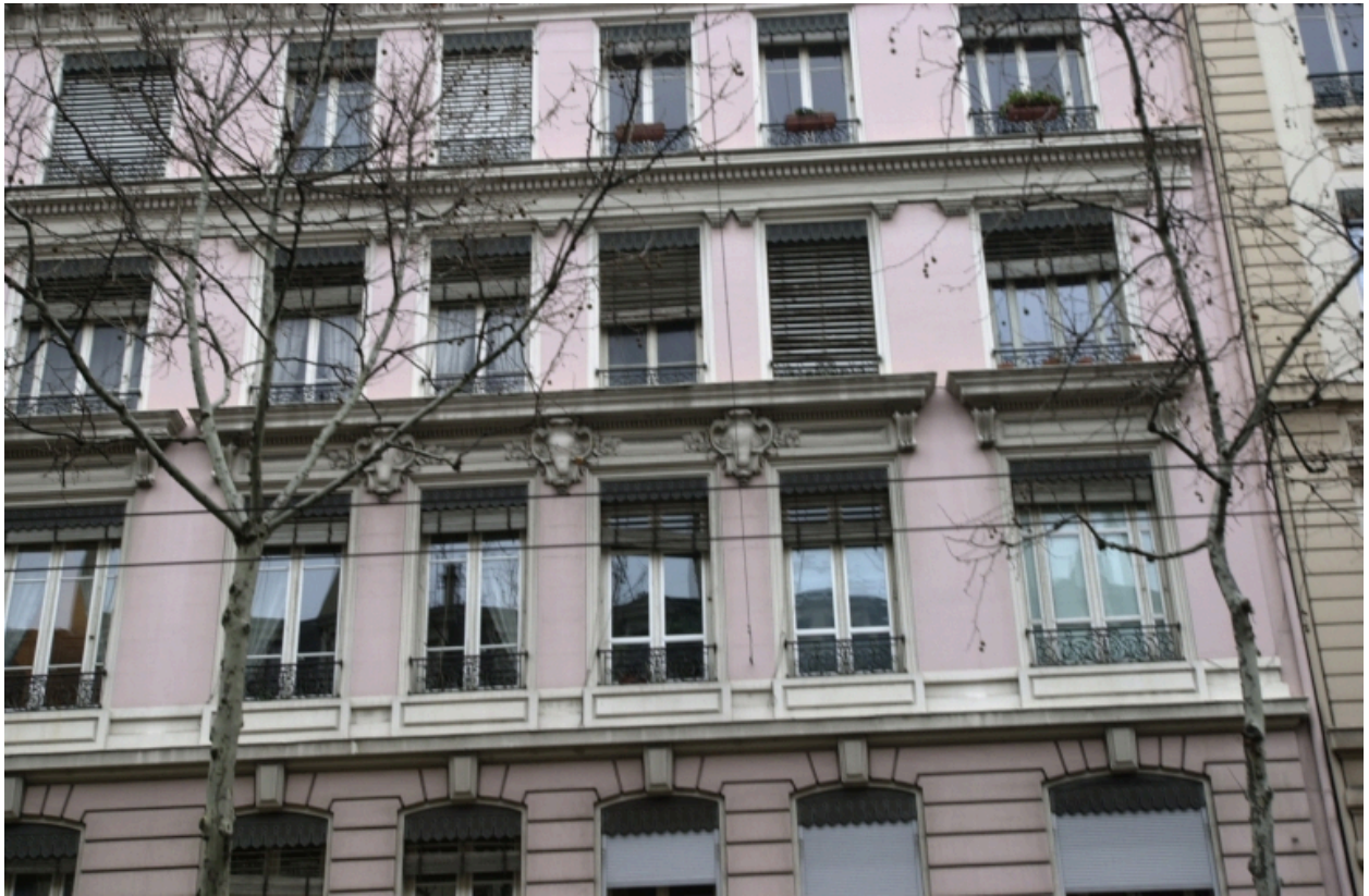
Détail de la travée centrale
