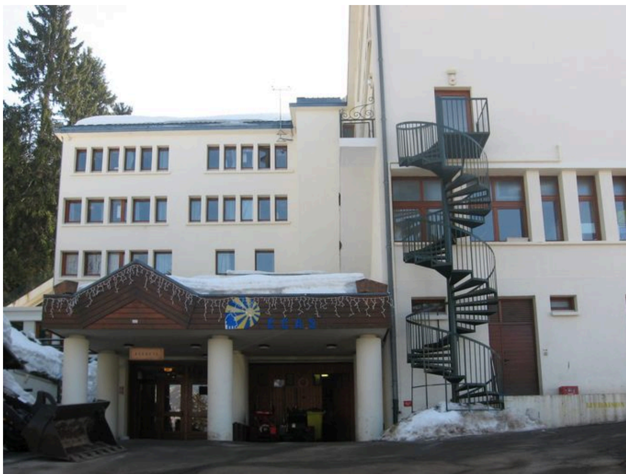
Vue de l'entrée, côté nord
