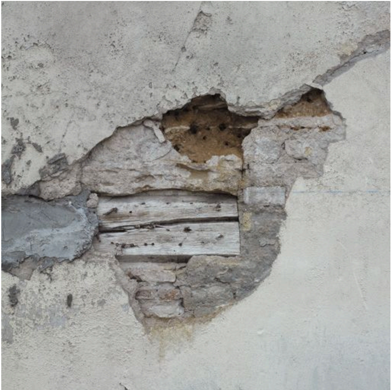
Corps de bâtiment nord. Rez-de-chaussée. Matériaux du mur nord
