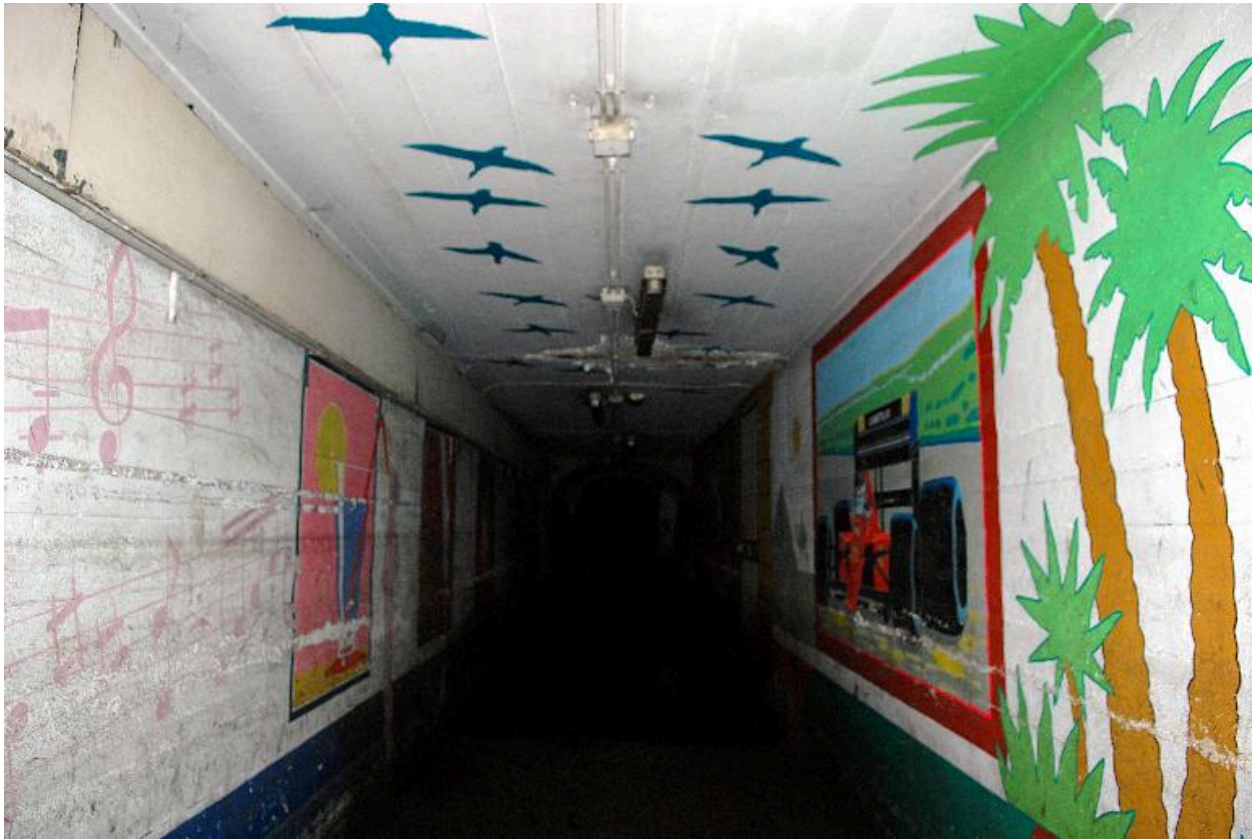
Le tunnel reliant Saint-Joseph à Saint-Paul : vue partielle
