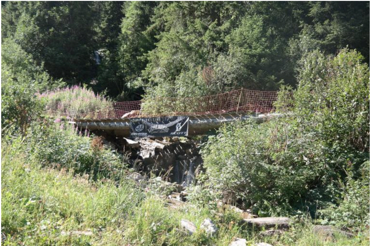
Passerelle VTT de Plaine Dranse, vue de la face aval
